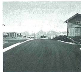
▲ 博物館道路改良舗装事業
