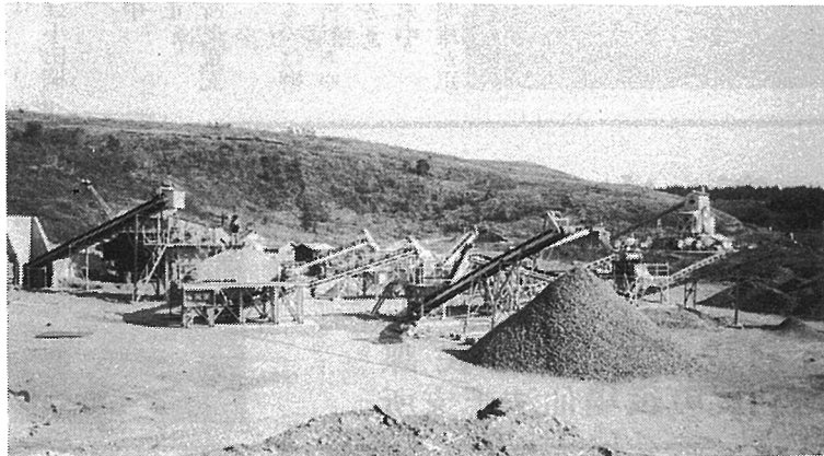
新しいプラント導入の 町営砕石事業所
