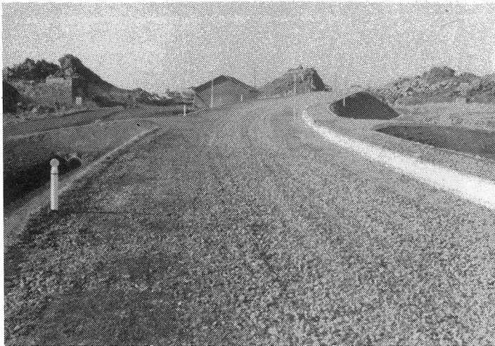
◀種富町公営住宅横の道路改良工事
