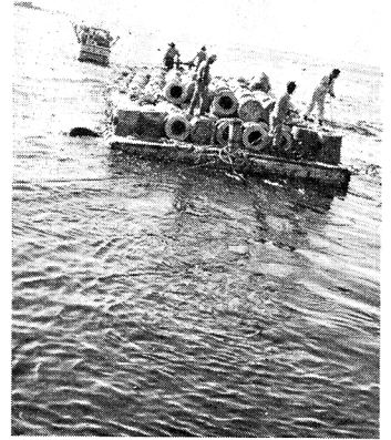
沈設中の投石 (コンクリートブロック)
